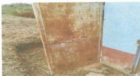
Foto 6: Se observa deterioro de puerta en baños.
